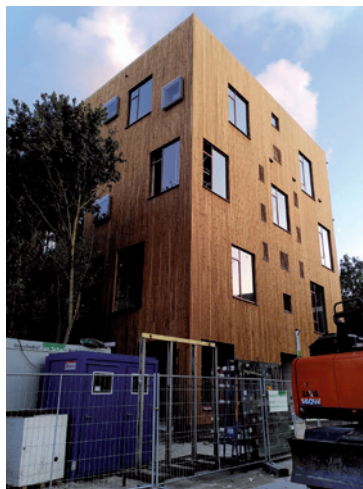
Het Nieuwe Bajesdorp in aanbouw, september 2023. Fotografie: Marije Baalman
