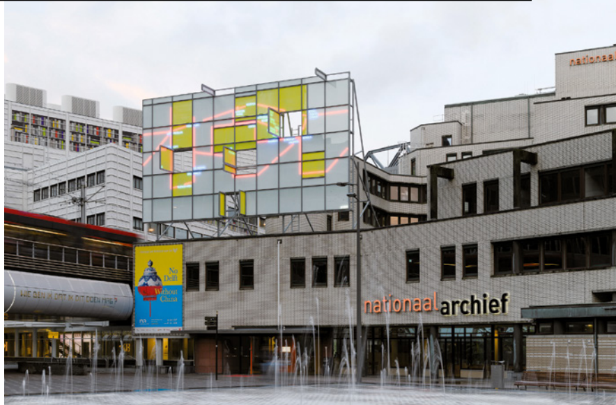
John Körmeling, Venster op de wereld , op het Nationale Archief, Den Haag, in opdracht van Atelier Rijksbouwmeester. © Atelier Rijks- bouwmeester
